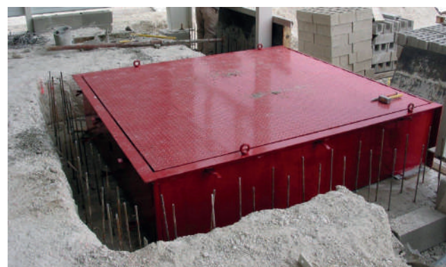
Pose du niveleur et de son cadre directement dans la forme
