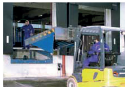
Démontage de l'ancien niveleur de quai et de l'ancien cadre de base et, le cas échéant, adaptation à l'aide de profilés d'adaptation
