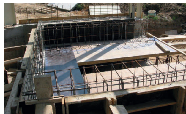
Pose du niveleur et de son cadre sur un support en bois pour création d'une fosse hayon
